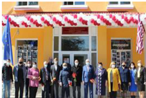
Darea în exploatare a clădirii LT „Andrei Vartic” după reparația capitală , 2021
