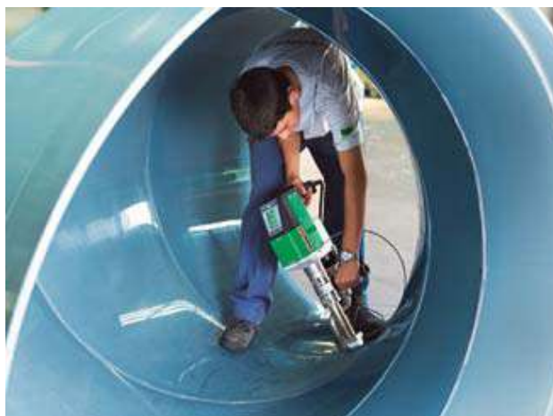
Рис.3.4. Экструзионная сварка внутреннего шва полимерной трубы
